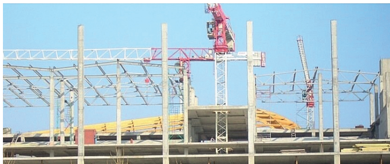
Рис. 1. Апрель 2008г. Монтаж КДК атриума
