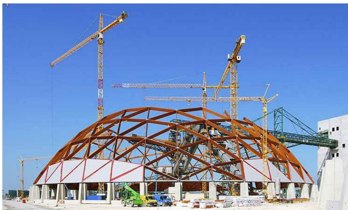
Рис. 1. Геодезический купол. Фото Rubner Holzbau
