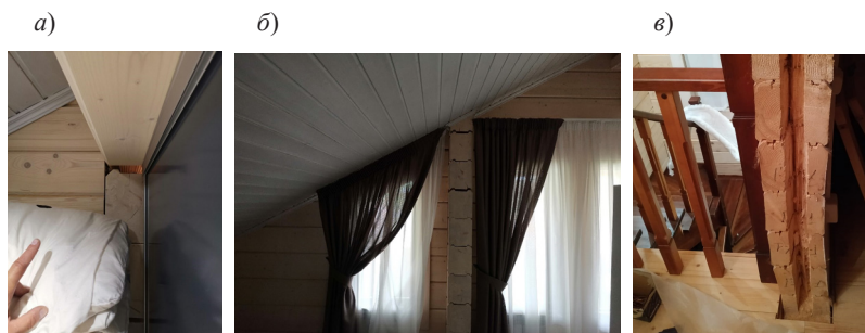
Рис. 3. Неравномерная усадка дома из клееного бруса:
