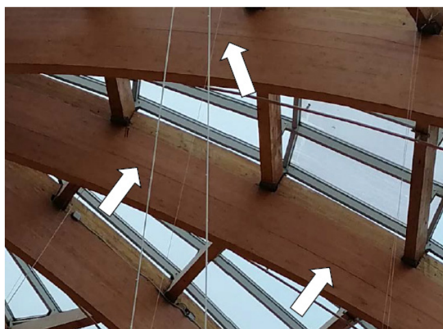
Рис. 5. Расслоение клеевого шва
