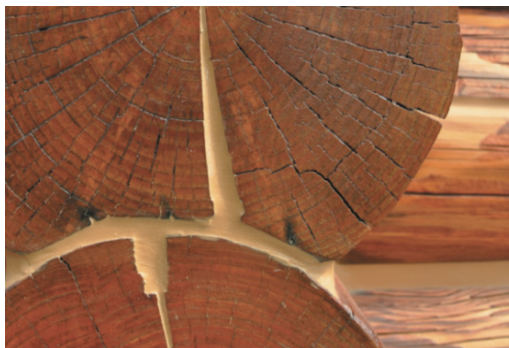
Рис. 4. Заполнение герметиком глубокой трещины, вызванной усушкой сруба
