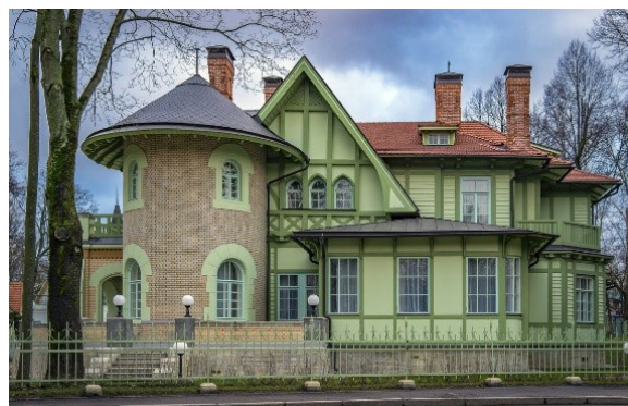
Рис. 1 и 2. Особняк Гаусвальд до реставрации и после [3]
