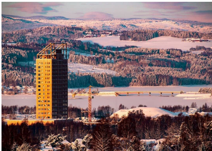
Рис. 6. 18-этажный деревянный дом в городе Брумунддал
