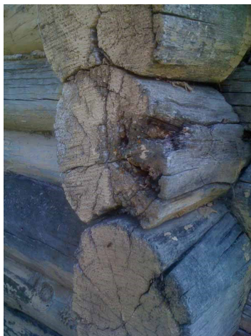
Рис. 3. Разрушение сруба
